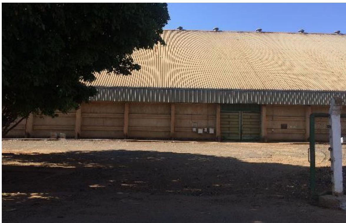
Vista Lateral – Armazém Graneleiro
