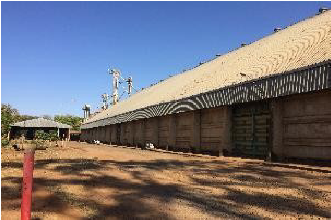
Vista Lateral – Armazém Graneleiro
